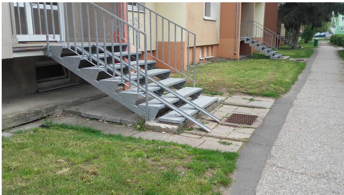
Obr.:Příklad současného provedení a kotvení schodišť před jednotlivými vchody.
