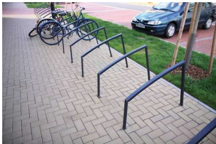
Obr.:Příklad stojanu na jízdní kola - černá ocelová konstrukce, gumový opěrník
